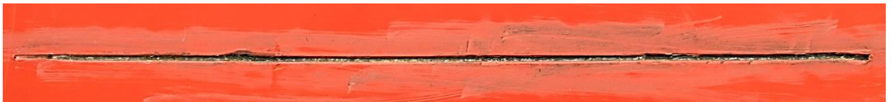
Delaminace nátěru v okolí řezu
